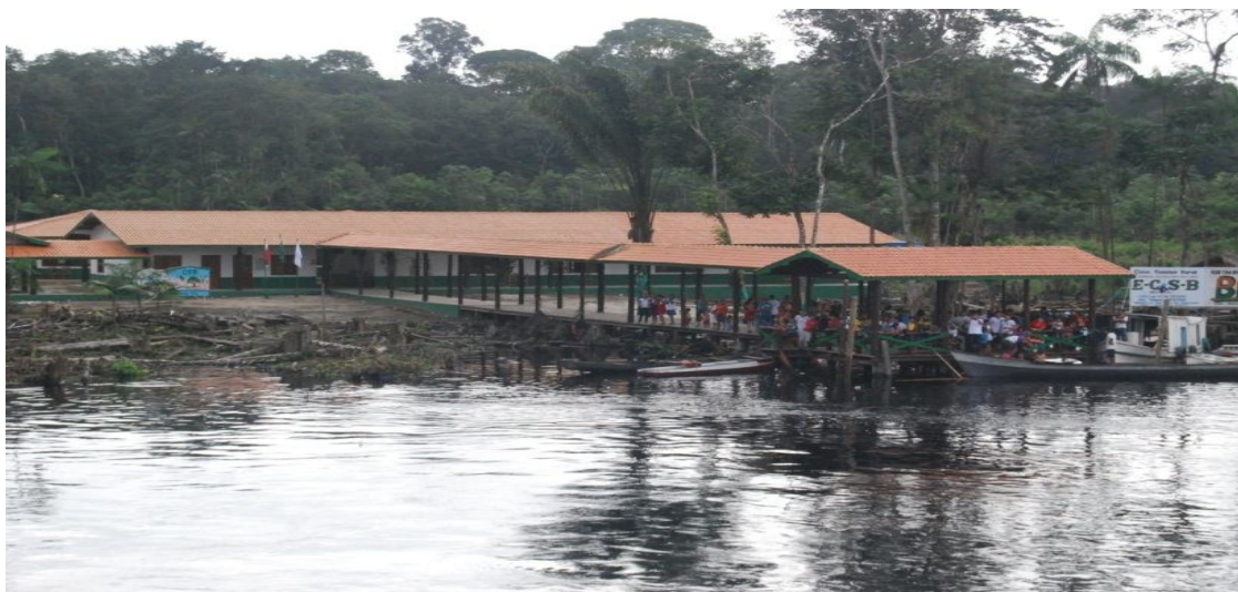
Fotografia 13- Visão externa da estrutura física da CFR de Breves.
