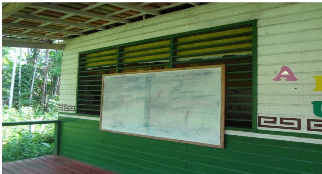
Fotografia 4 - Pátio da escola Santa Izabel localizada no Rio Jupatituba.
