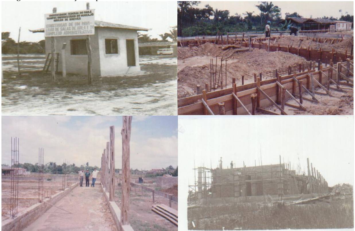
Fotografia 3 – Construção do prédio da UFPA em Breves
